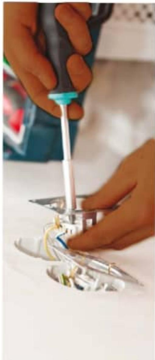
Montage d'appareillage
