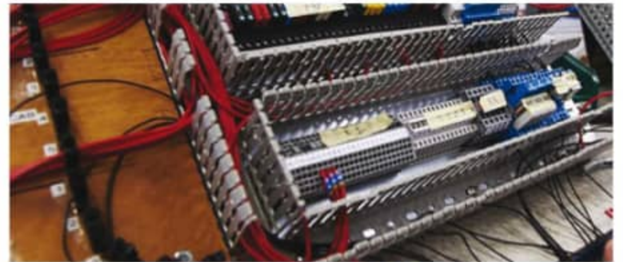
Câblage d'un coffret électrique
